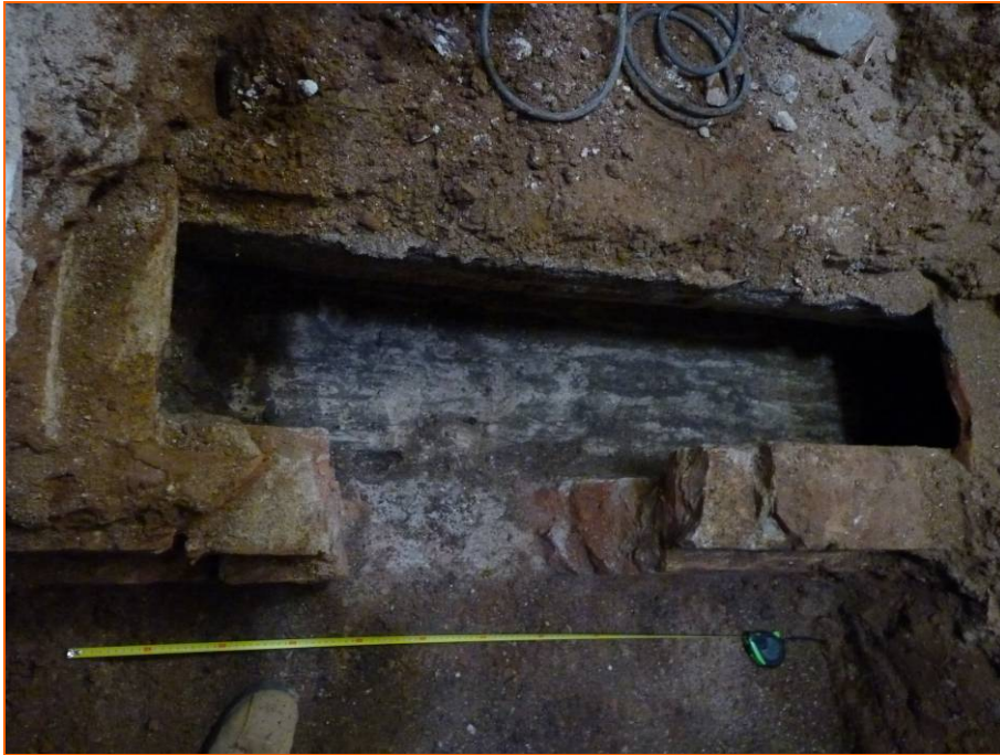
Foto 7. Interior de la canalització UE.3.
