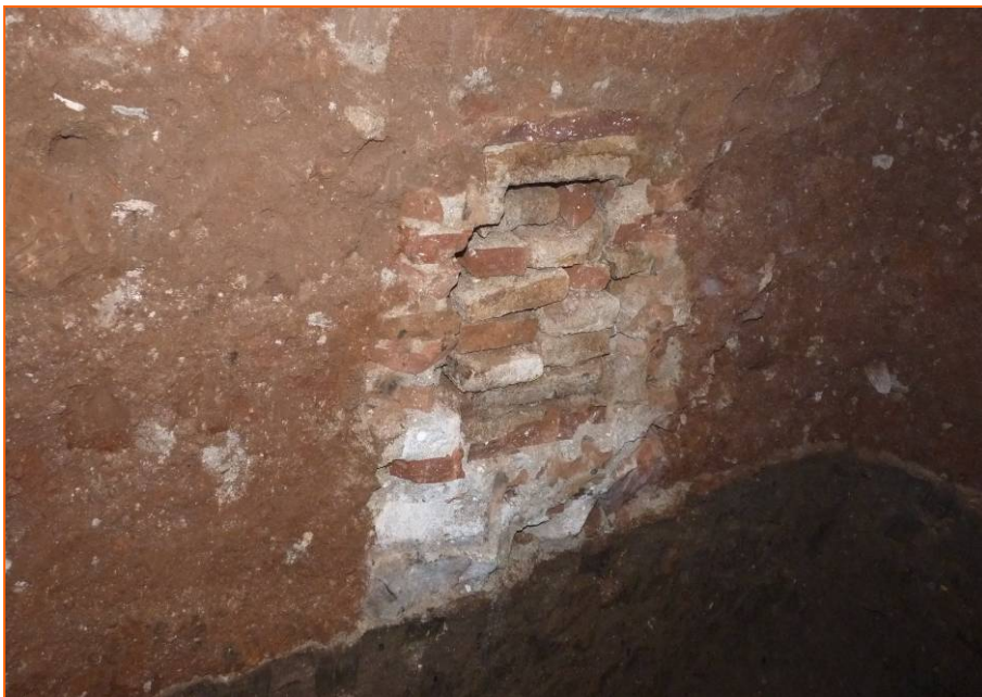
Foto 10. UE.2 i la canalització UE.3 sobre les argiles UE.5, tallades per la negativa de construcció UE.4.
