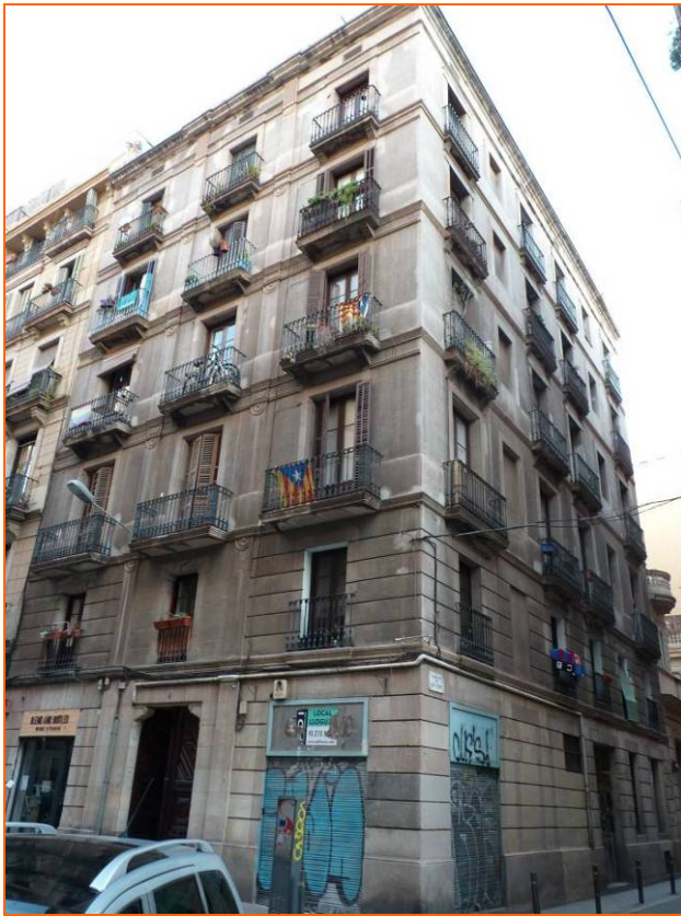
Foto 1. Edifici plurifamiliar objecte de la intervenció.
