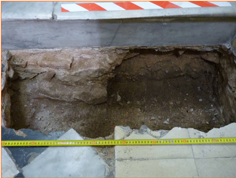
Foto 3. Rasa per a la creació del nou esglaó de l'escala.
